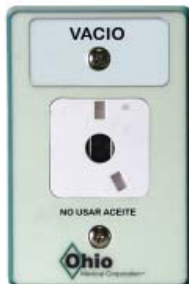
Salida de Consola compatible con Ohio Diamond
